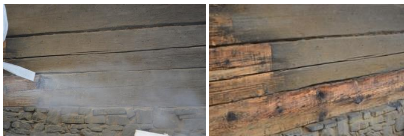
Obr. 3 Aplikácia technológie čistenia povrchu konštrukčných prvkov suchým ľadom in situ .
