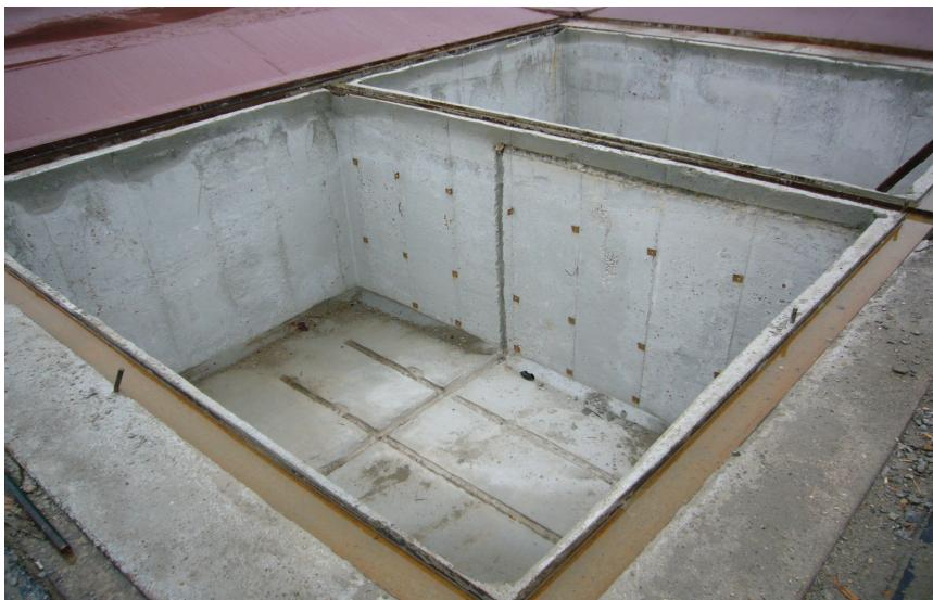
Рис. 6 Общий вид двух бассейнов для проварки ванчесов в фабрике „Обнова”
