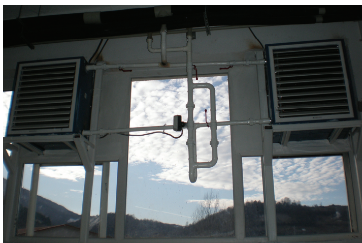
Рис. 4 Общий вид реализованной тепловоздушной инсталляции
